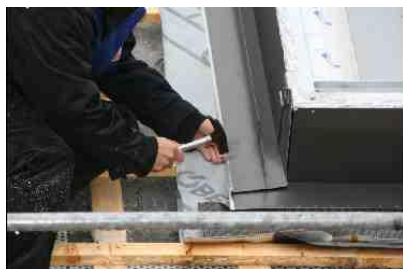
Befestigung eines Eindeckrahmenblechs mit Wasserablauffrinne am Stapelspeicher
