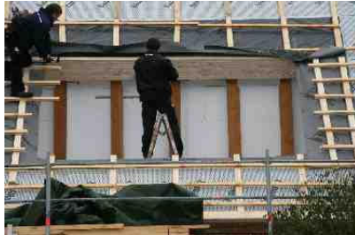
Ein Wechselholz (12/20) genügt zur Unterstützung der Einbauöffnung für das Panorama-Fenster
