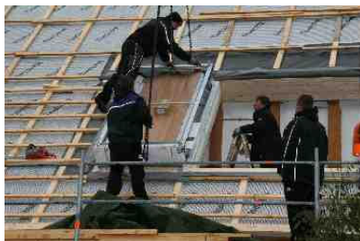
Dank der maßgenauen Dachöffnung passt der Stapelspeicher hier auch exakt hinein
