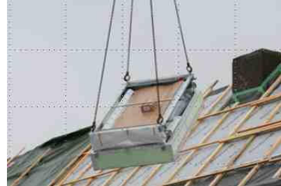
Mit Hilfe eines Autokrans wird als Erstes der Stapelspeicher zur Einbauöffnung transportiert
