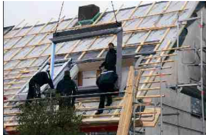
Der große Blendrahmen wird mit Hilfe des Autokrans in die Einbauöffnung bugsiert
