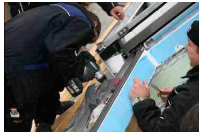
Der Rahmen wird an einer unterhalb der Dachöffnung montierten Latte befestigt
