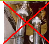
Metallkragen = Wärmebrücke
