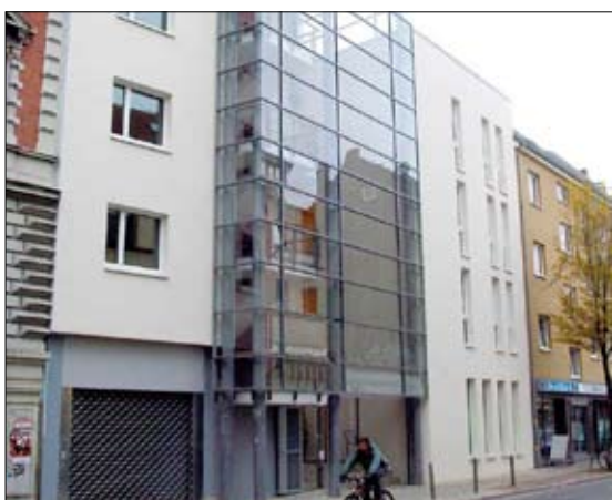
Paul-Roosen-Str. 9-13, Hamburg-St.Pauli 10 WE + 2 GE Mehrfamilienhaus (Neubau 2004) Energiebezugsfläche nach PHHP: 810 m 2 Baukosten: 1572 € netto / m 2 Wohn- und Nutzfläche Architekt: Andreas Thomsen, Bauherr: STEG
