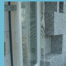
Energiesparende Fenster und Wärmedämmung
